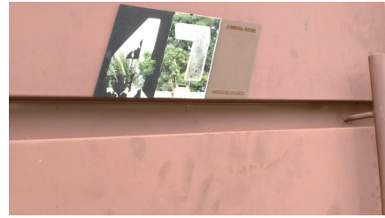
Representação Fachada Descrição Identificação Imóvel (uma das numerações não está no local) Data Foto 29/06/2017
