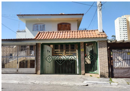
Representação Fachada Principal Descrição Data Foto 23/04/2024
