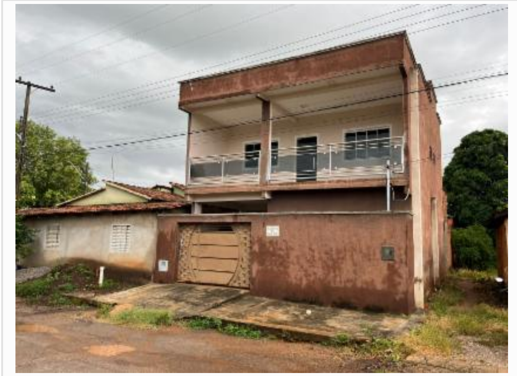
Fachada do avaliando
