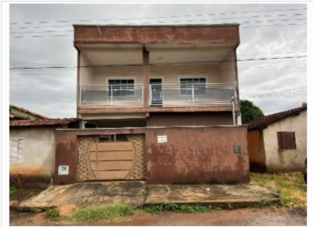
Fachada do avaliando
