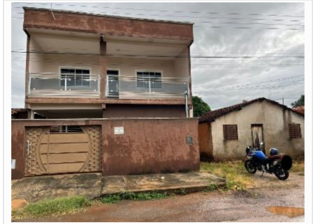
Fachada do avaliando
