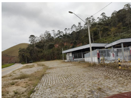
Representação Fachada Principal Descrição Data Foto
