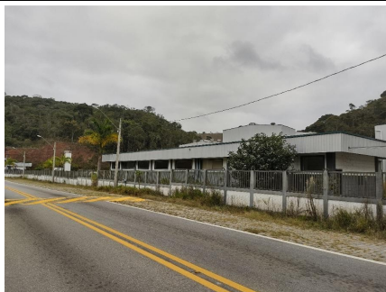
Representação Fachada Principal Descrição Data Foto
