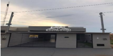
Representação Fachada Principal Descrição Data Foto 27/06/2023
