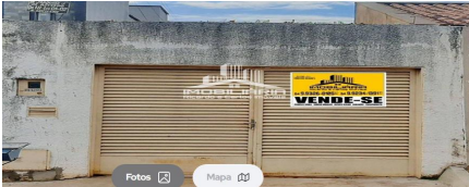
Representação Fachada Principal Descrição Data Foto 27/06/2023
