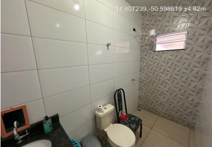
Representação Banheiro Descrição Data Foto 23/06/2023
