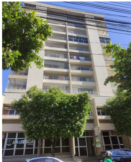
Representação Fachada Principal Descrição
