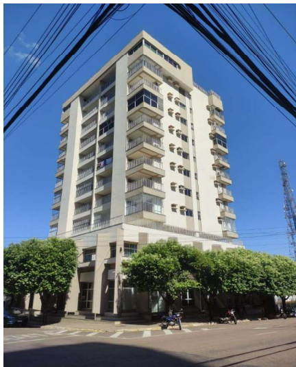
Representação Fachada Principal Descrição
