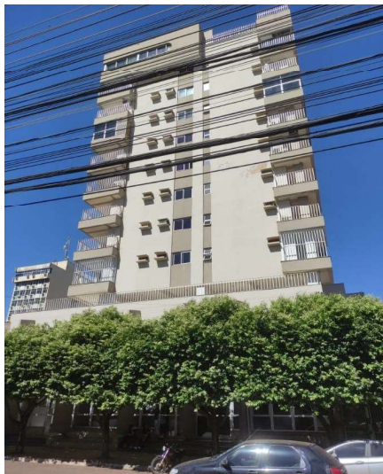
Representação Fachada Principal Descrição
