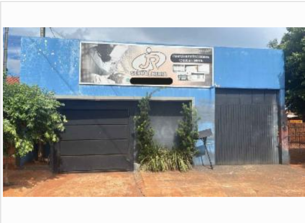
Fachada do avaliando
