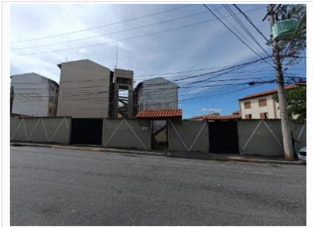
Condomínio do lado esquerdo
