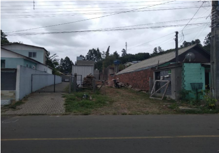
Representação Fachada Principal Descrição Data Foto 21/04/2023
