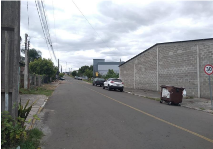
Representação Vista da Rua Descrição Data Foto 21/04/2023
